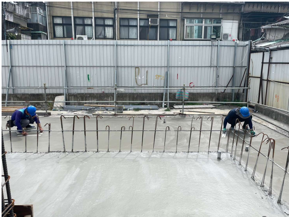
1F 底板灌漿、粉光施作 112.10.13
