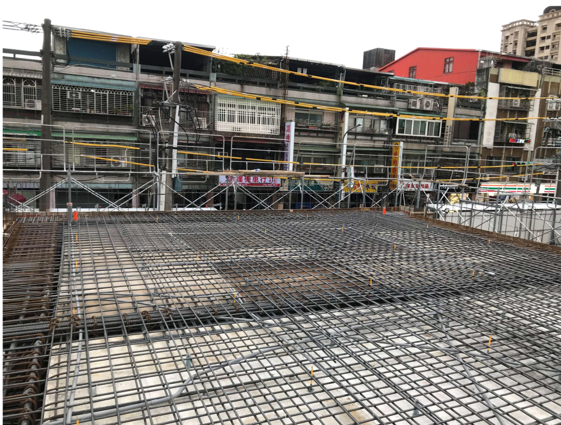
1F 天花板(2F 底板)鋼筋綁紮完成 112.11.13
