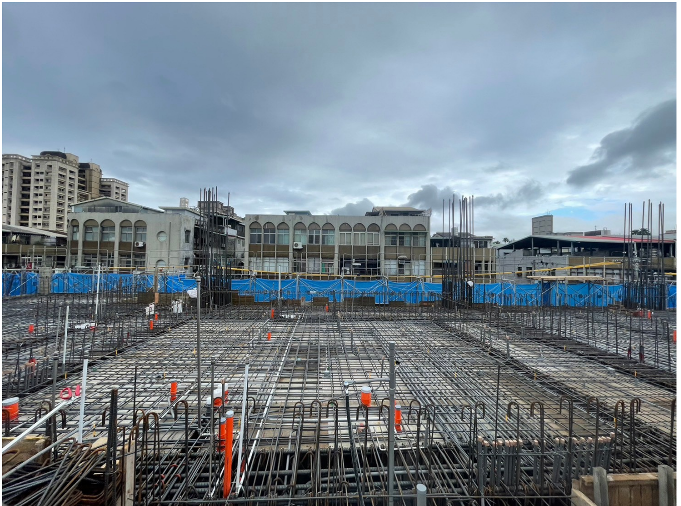
2 樓天花板(3F 底板)鋼筋綁紮完成 112.12.12
