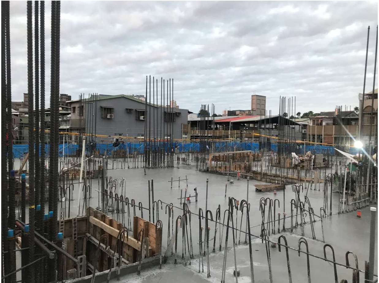
3F 底板灌漿完成 112.12.13
