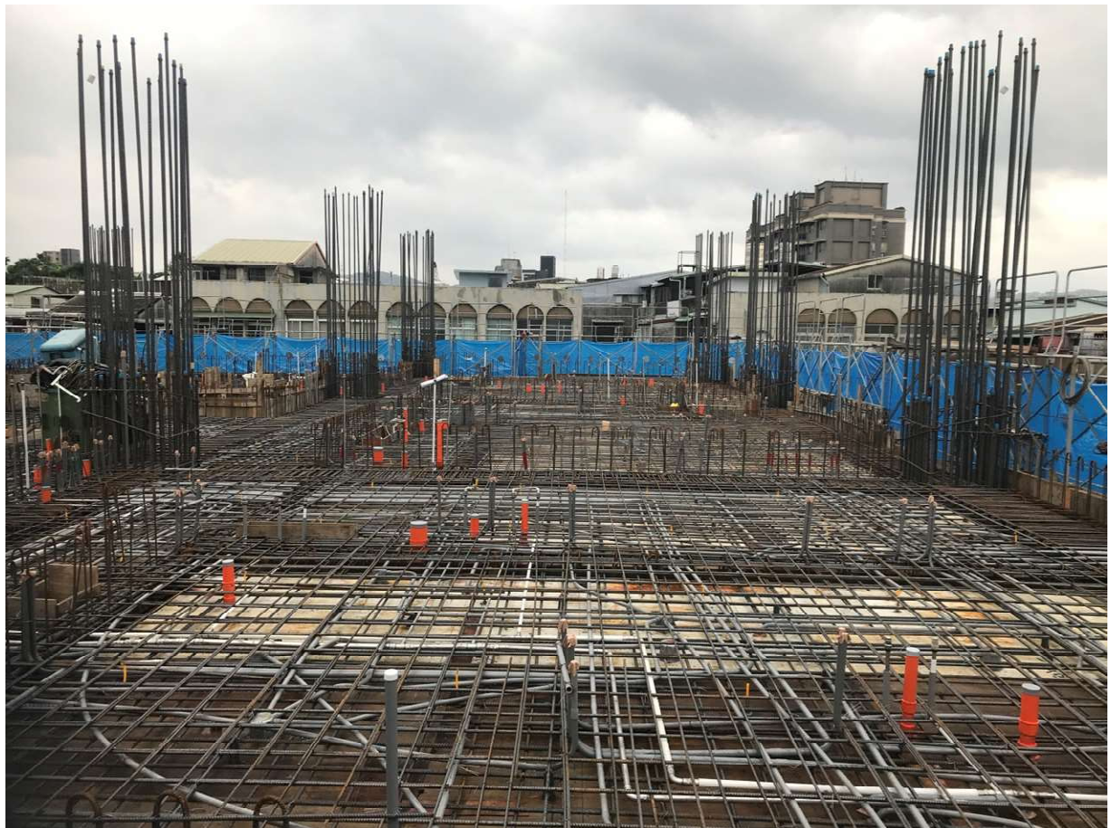
3F 天花板(4F 底板)綁紮完成 113.01.03
