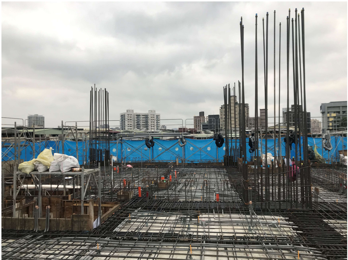
4F 天花板(5F 底板)綁紮 113.01.24
