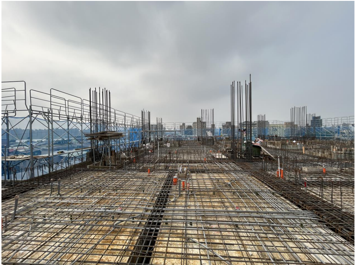
7F 天花板(8F 底板)鋼筋綁紮 113.04.12
