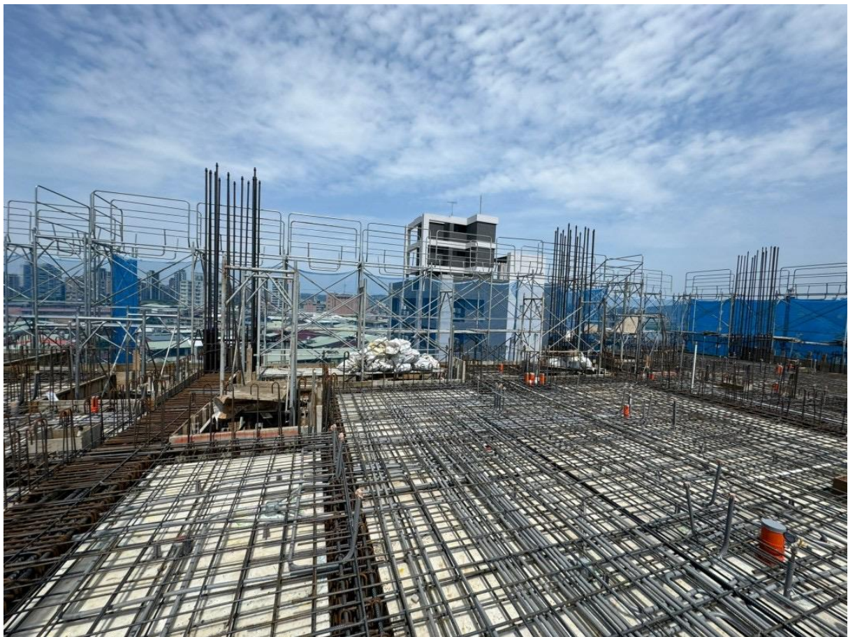
8F 天花板(9F 底板)鋼筋綁紮 113.05.07
