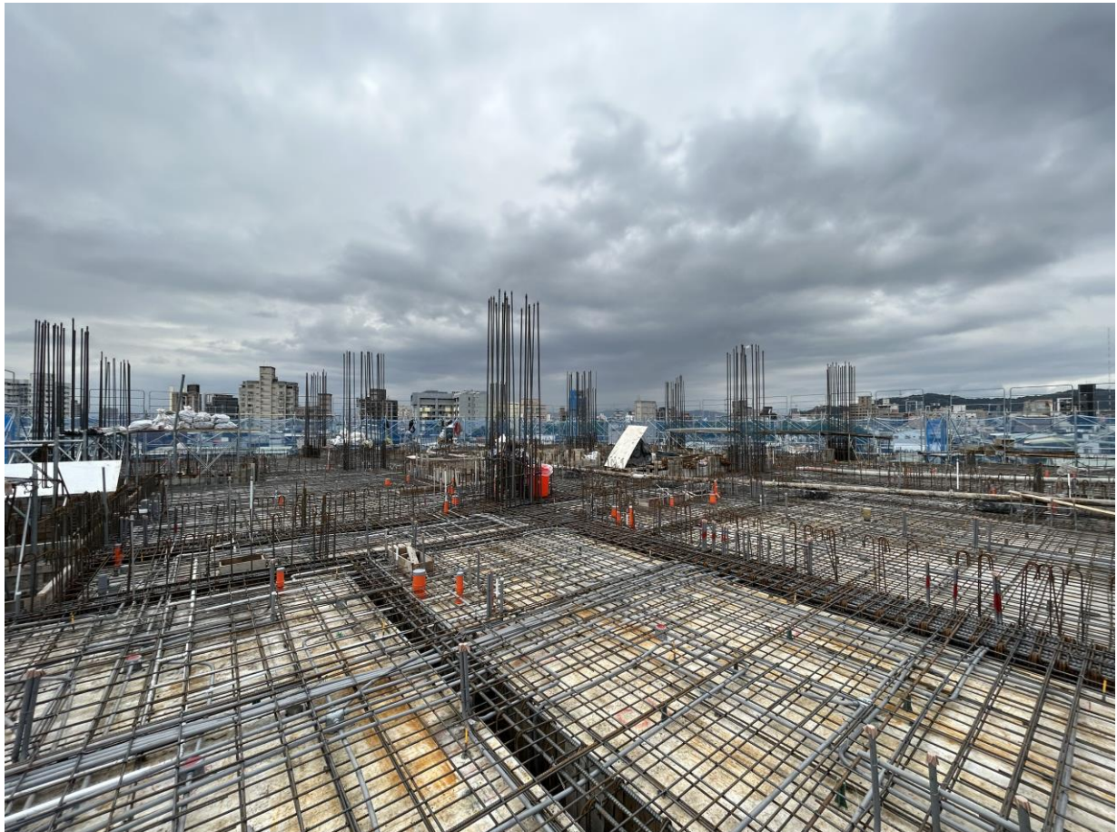
6F 天花板(7F 底板)鋼筋綁紮 113.03.19
