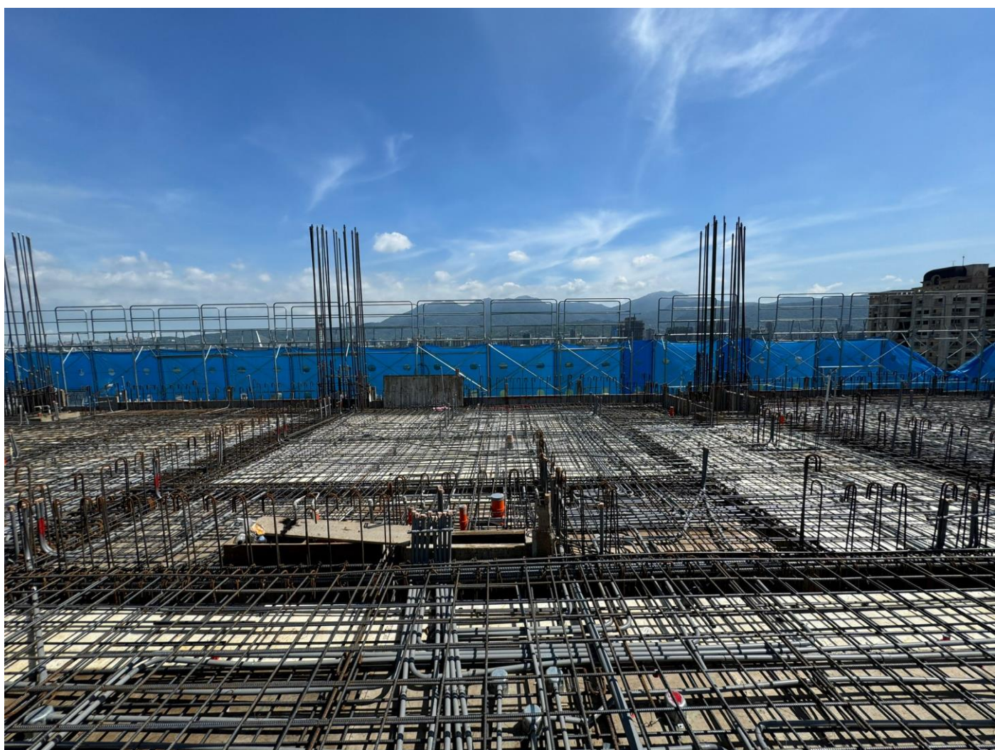
11F 天花板(12F 底板)鋼筋綁紮 113.07.11
