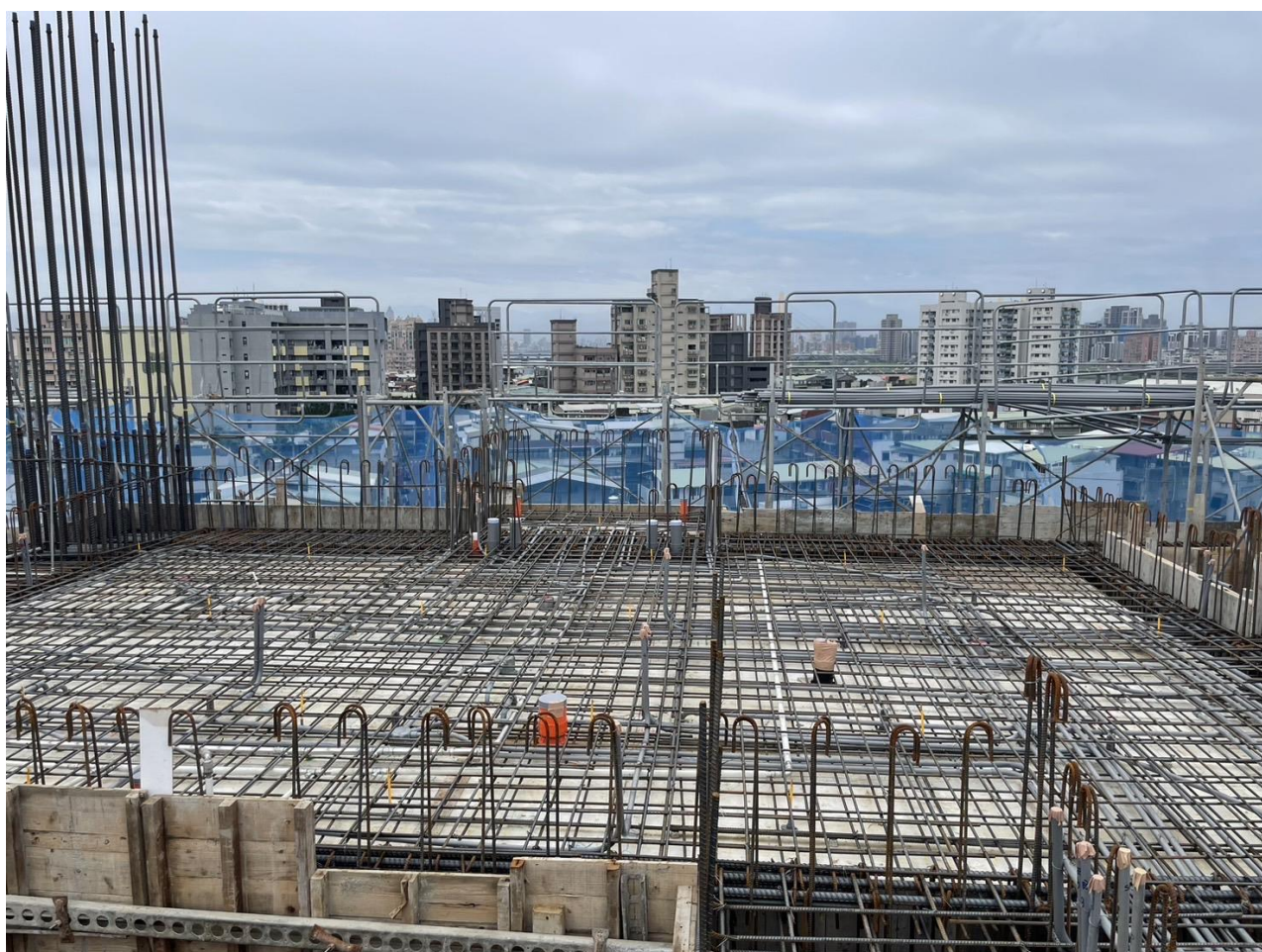
9F 天花板(10F 底板)鋼筋綁紮 113.05.29
