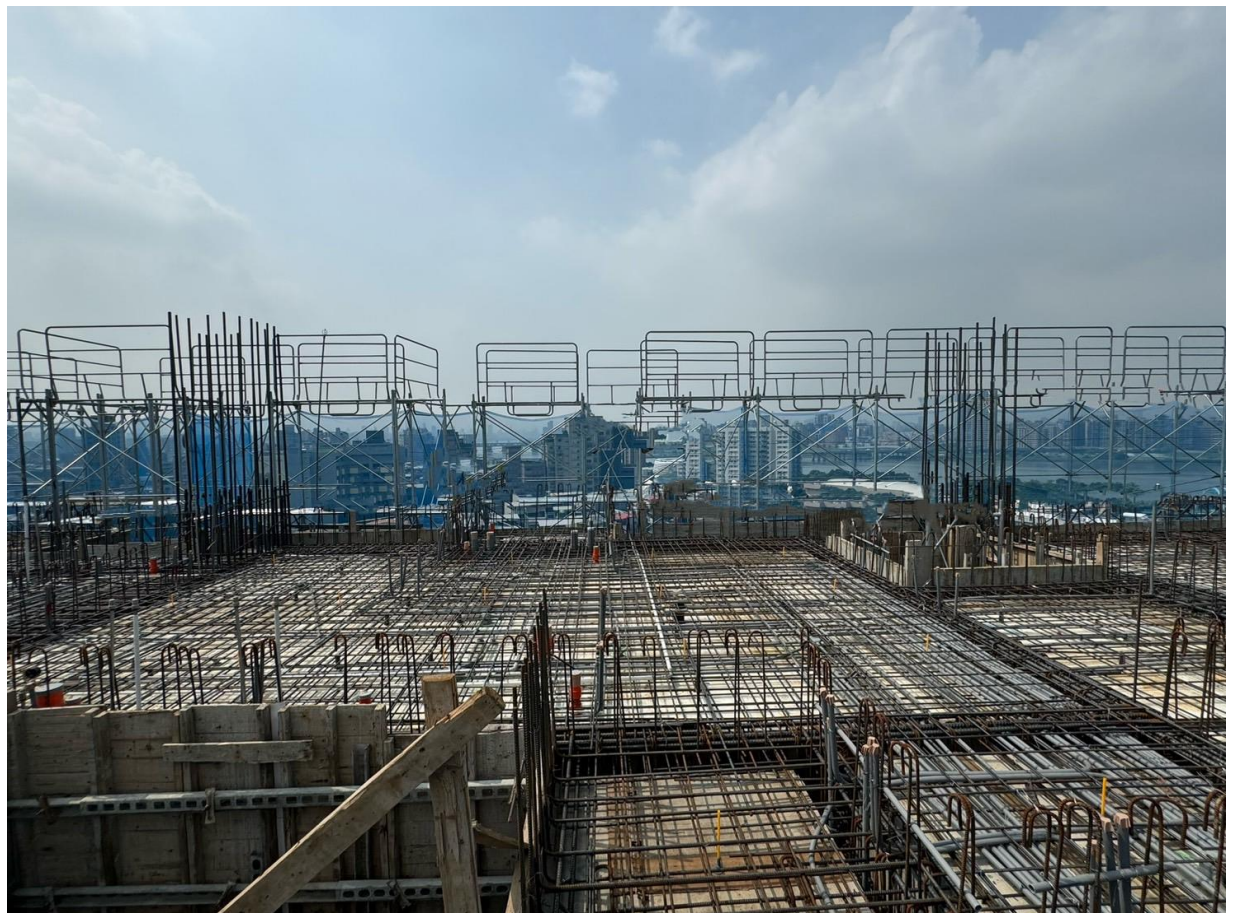
13F 天花板(14F 底板)鋼筋綁紮 113.08.30
