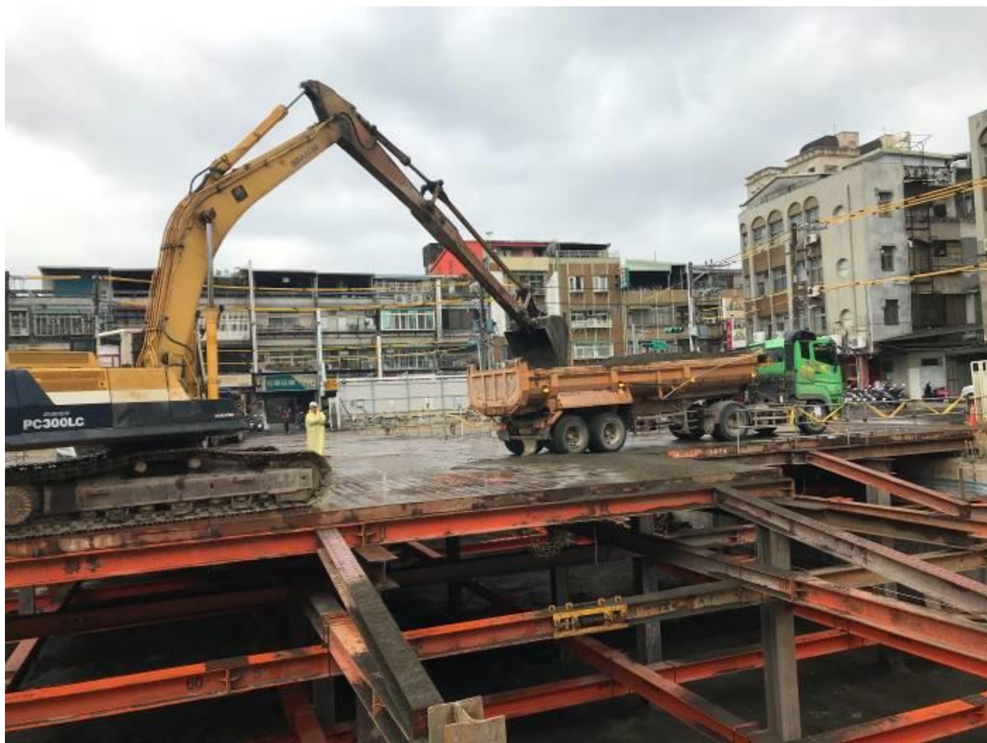
1111212 第三層土方開挖
