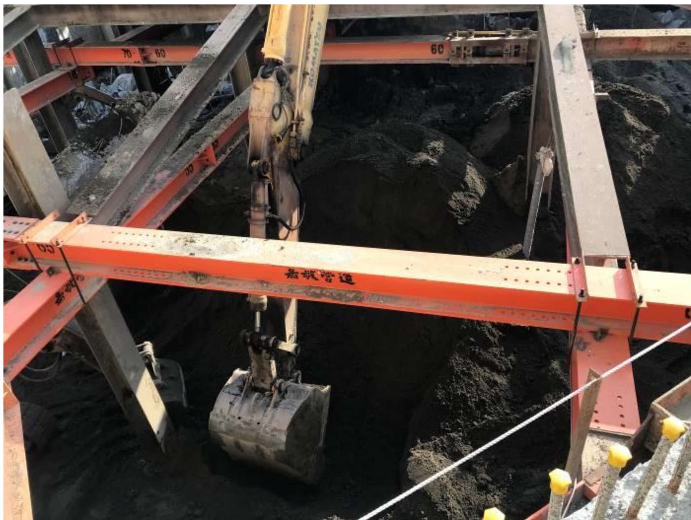
1111129 第二層土方開挖
