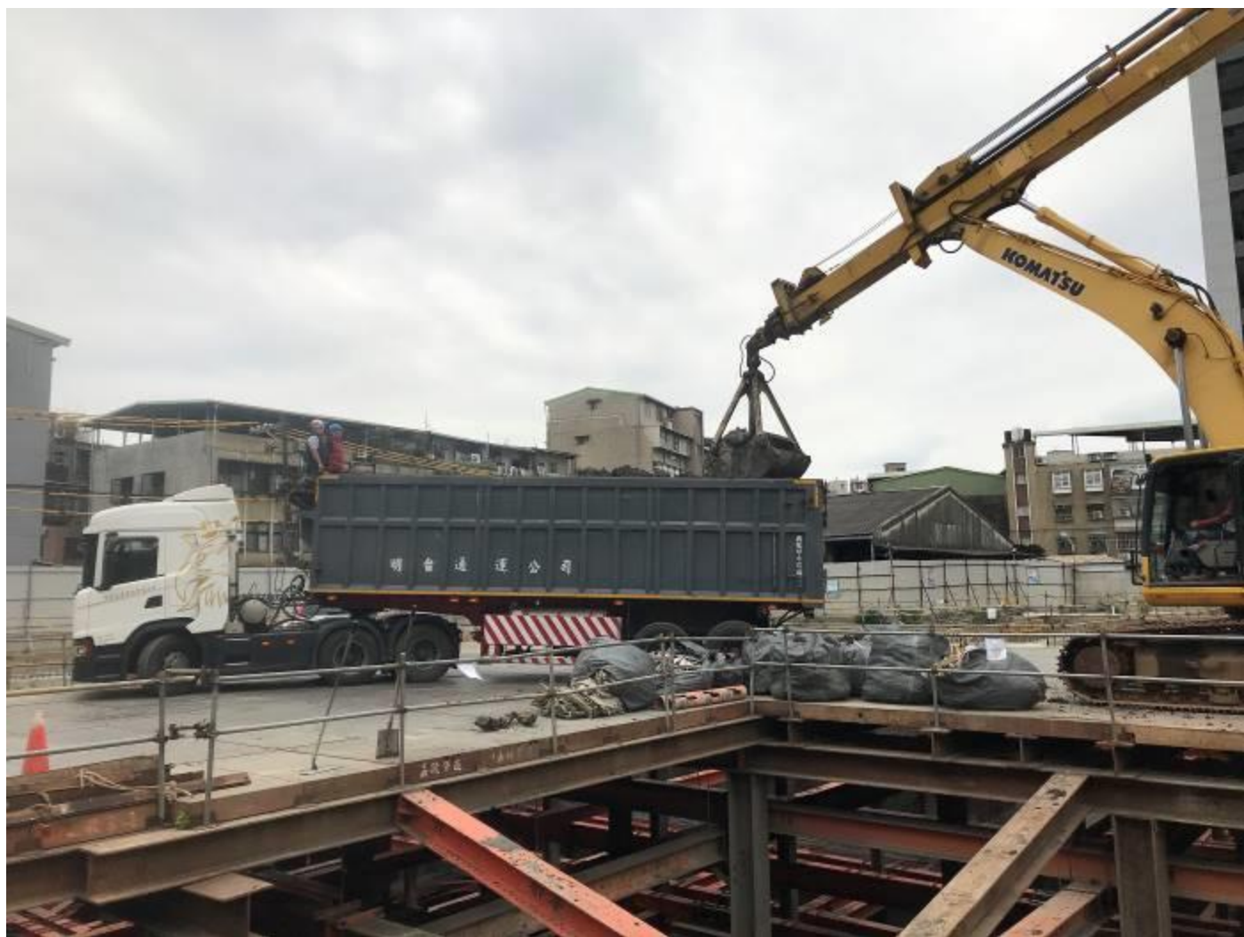
1120304 第五層土方開挖
