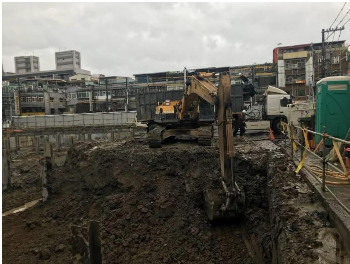
1111101 第一層土方開挖
