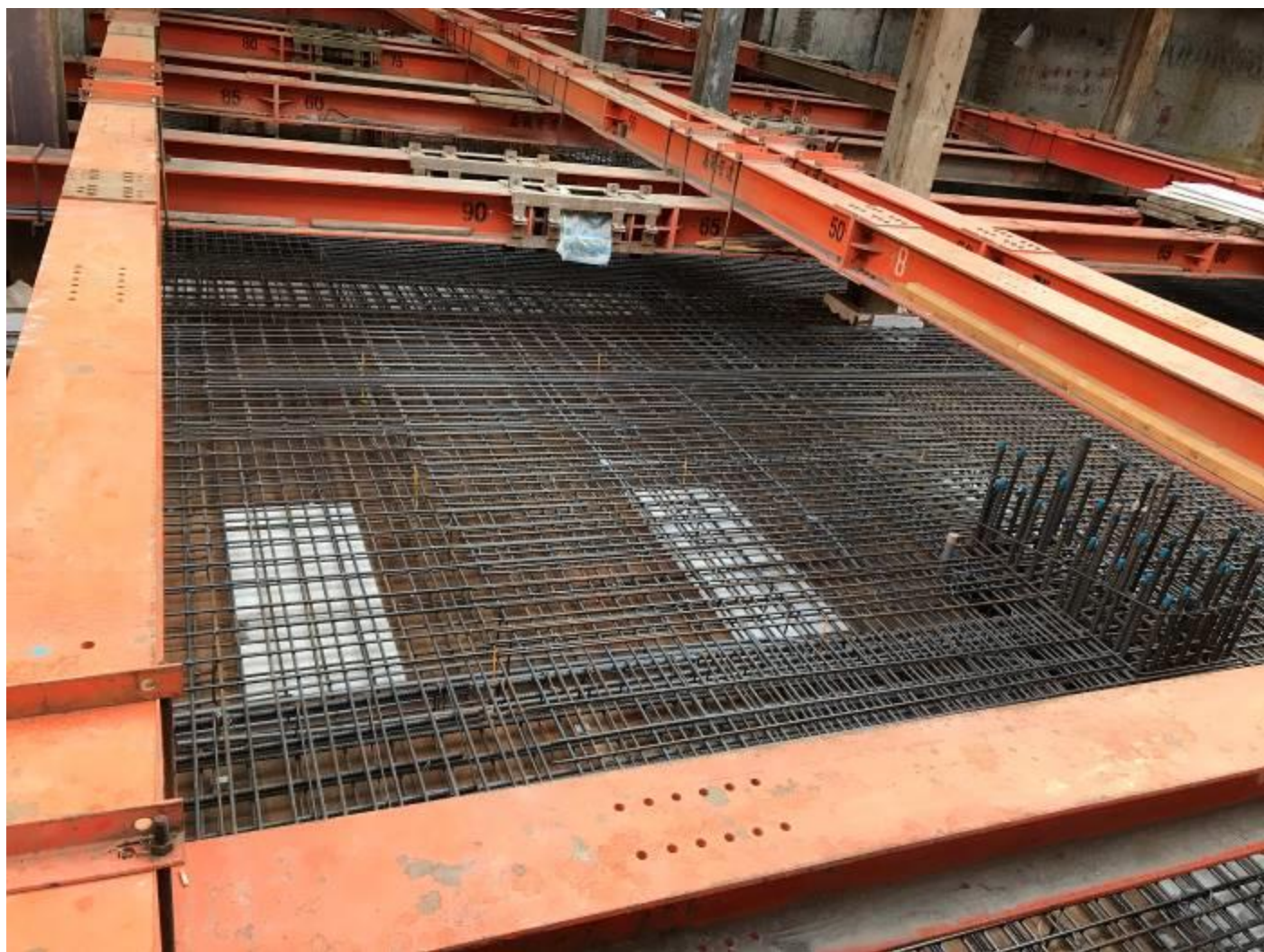
B3 地板鋼筋綁紮完成 1120515
