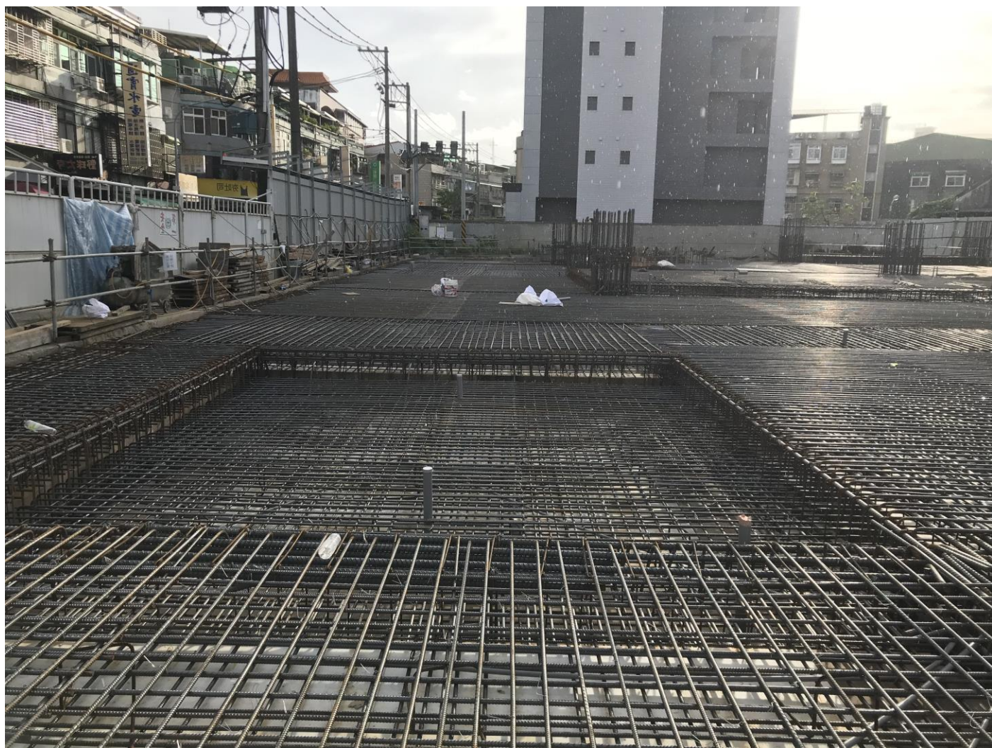
1F 鋼筋綁紮完成 1121005
