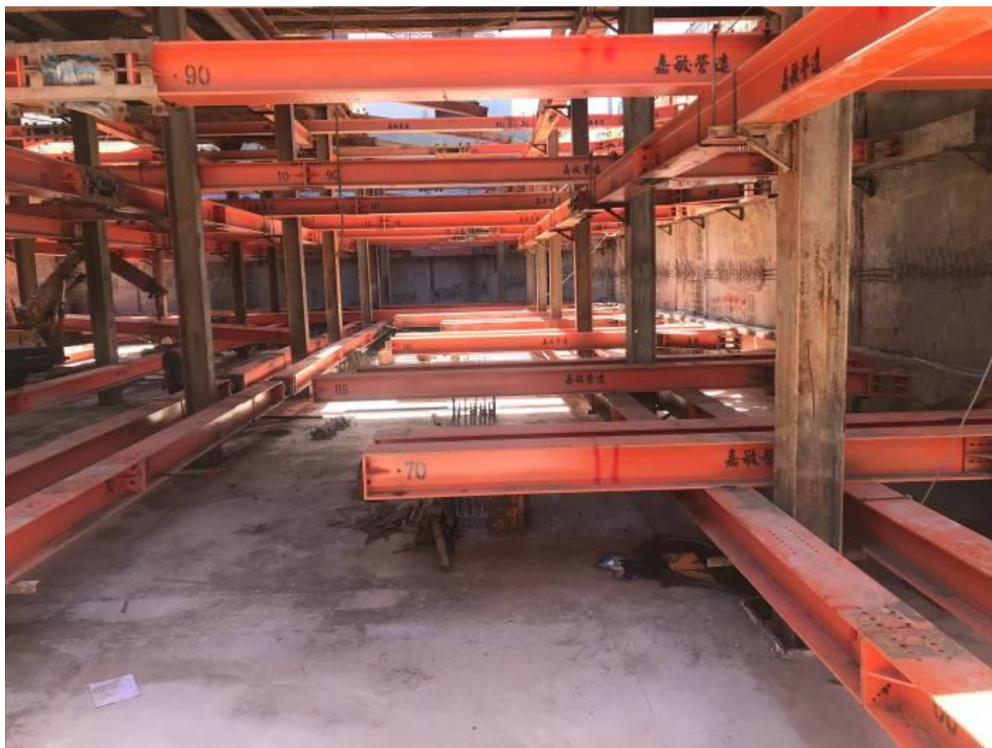
B3 安全支撐拆除 1120529
