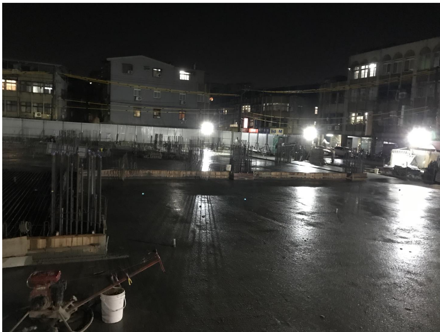
1F 底板灌漿完成 1121012
