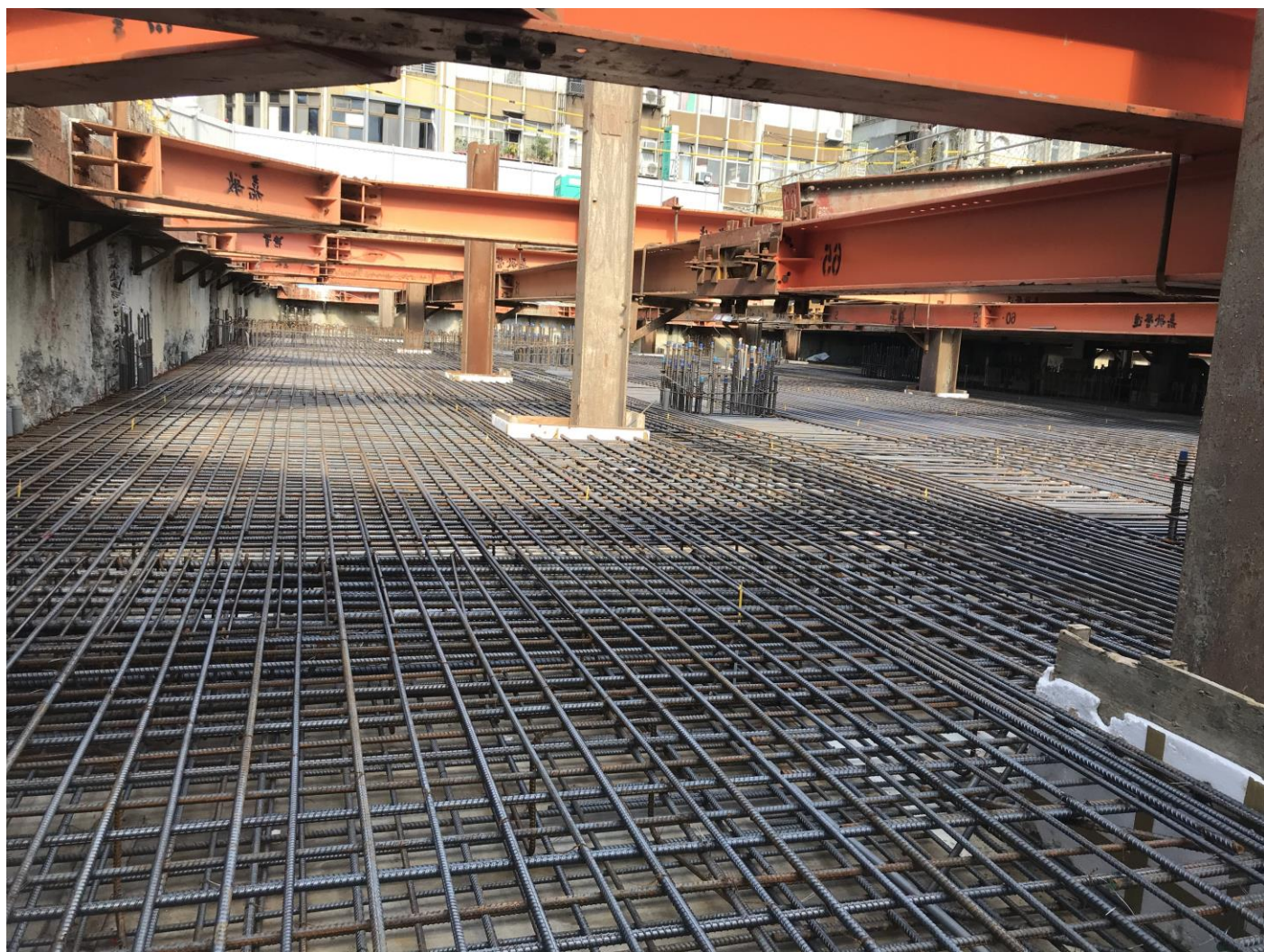
B1 鋼筋綁紮完成 1120814
