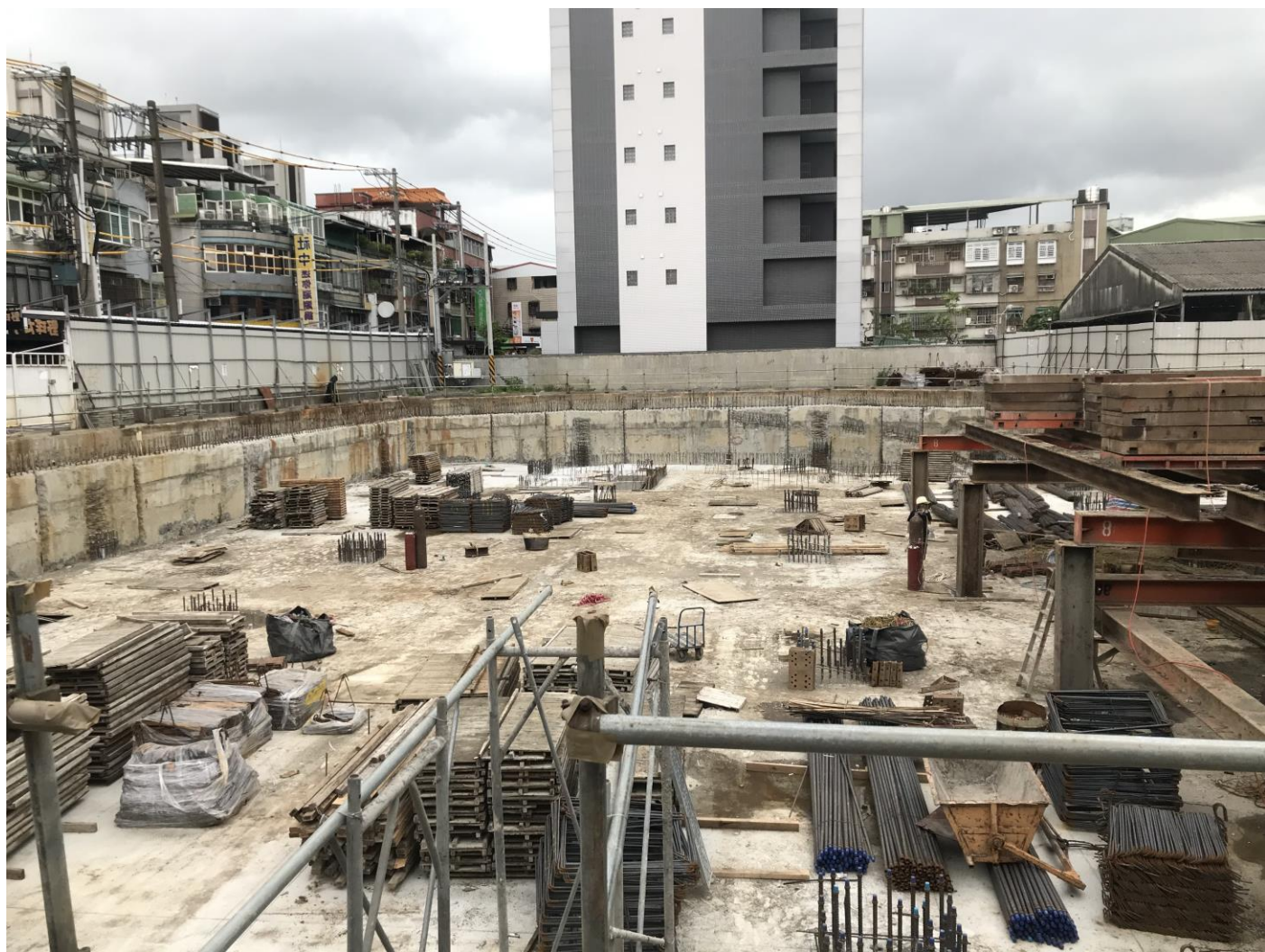
B1 安全支撐拆除 1120906
