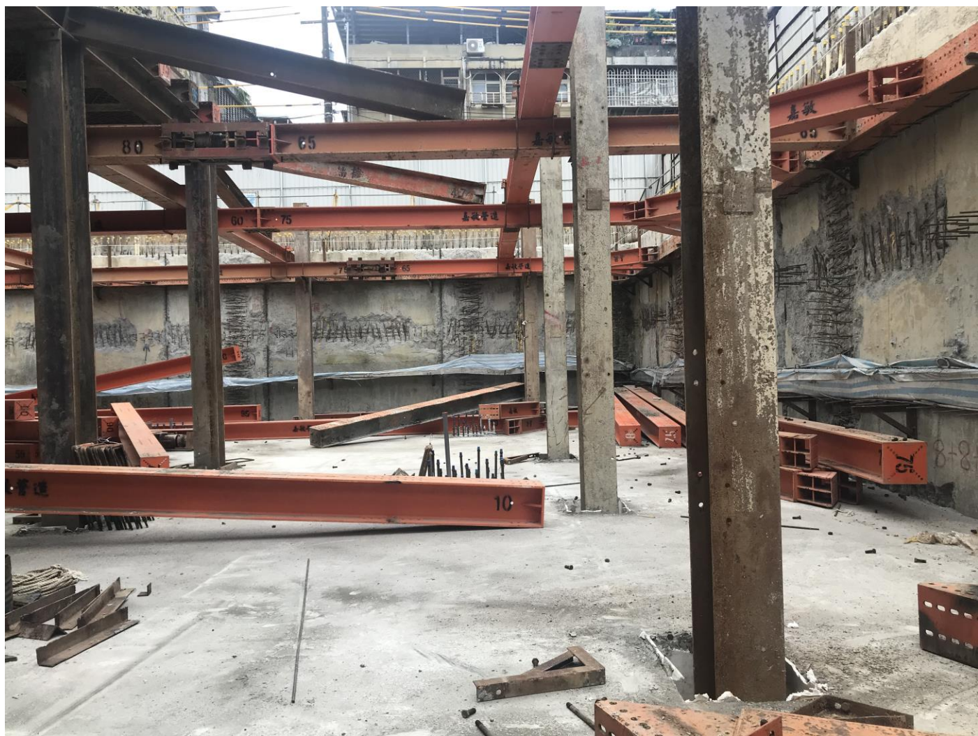
B2 安全支撐拆除 1120713
