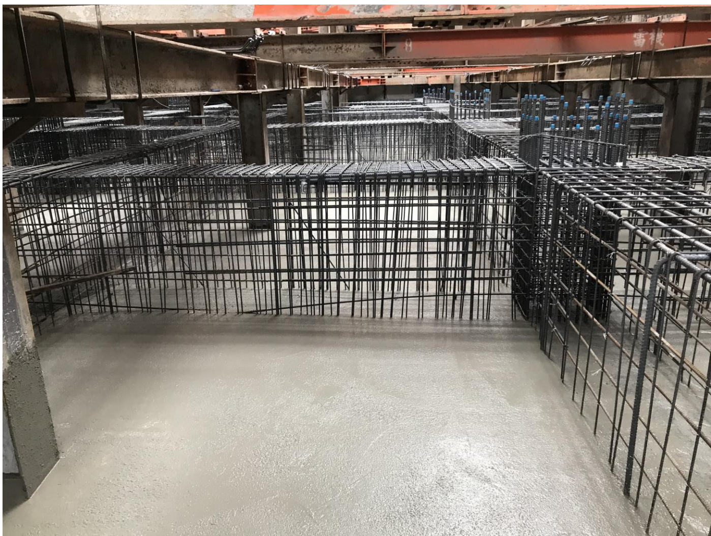
基礎板灌漿過程 1120321
