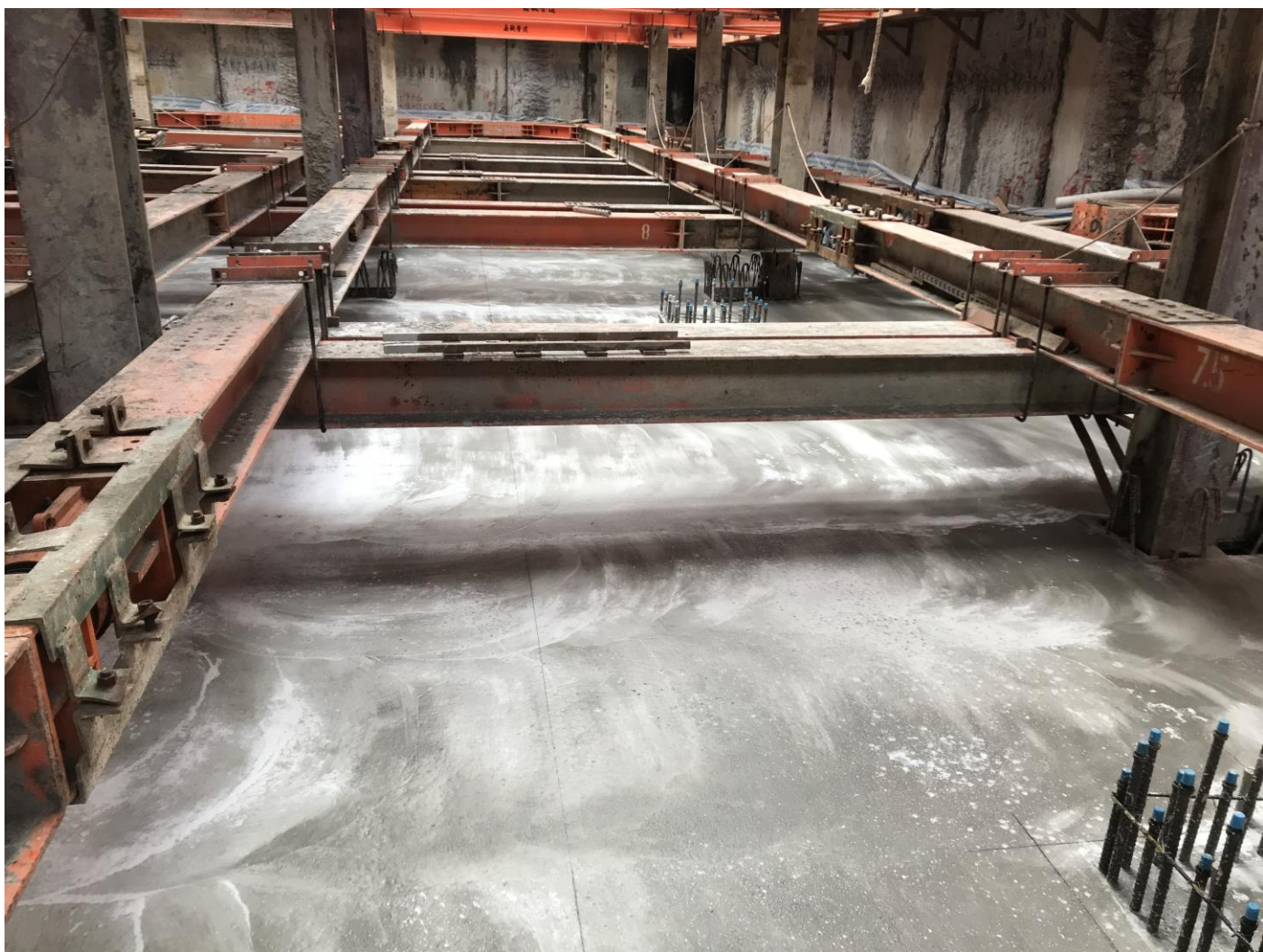
水箱蓋板完成 1120408
