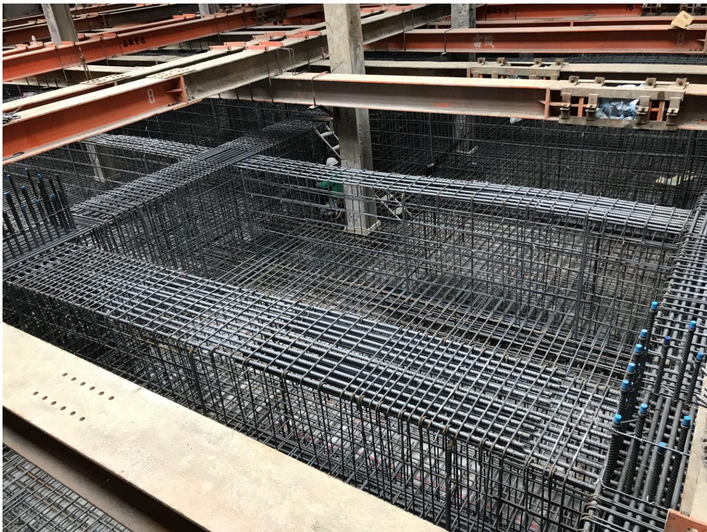
基礎版鋼筋綁紮完成 1120320
